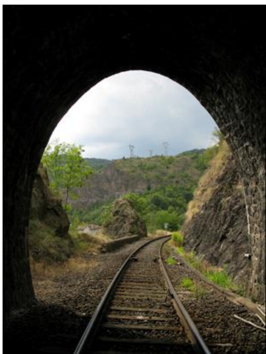
L'entrée du tunnel
