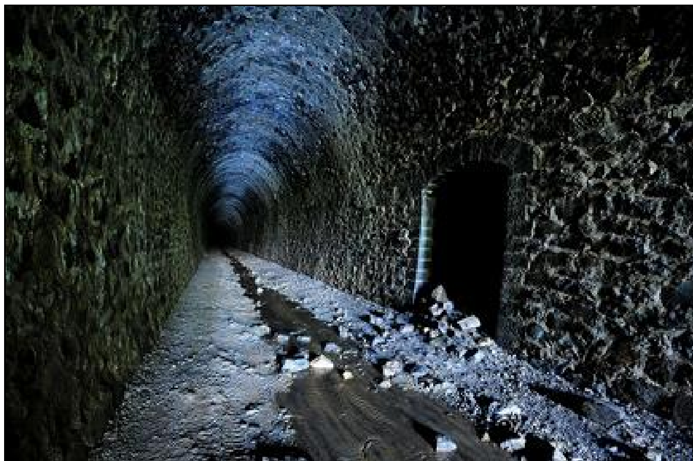
Ci-dessus et ci-dessous, la galerie peu après l'entrée
