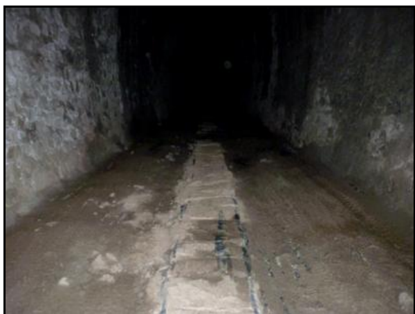
Le drain central recouvert de grosses dalles
