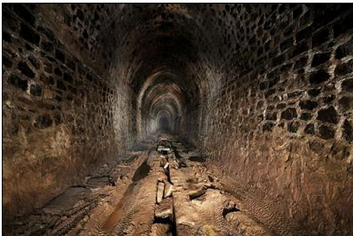
Le radier inachevé avec le drain central bien visible
