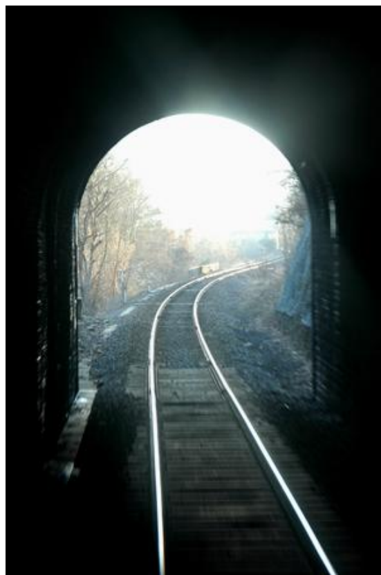
La sortie vue de l'intérieur
