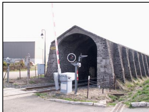
La sortie Les contreforts latéraux sont ici bien visibles
