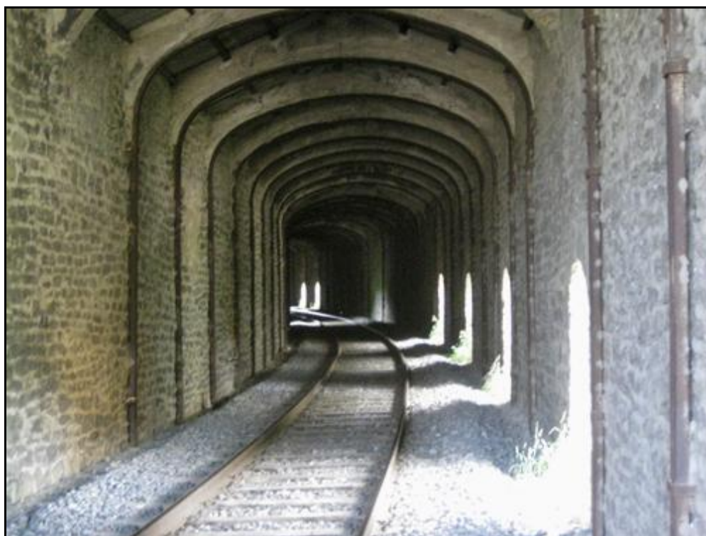
Ci-dessus et ci-dessous, l'intérieur de la galerie, en regardant vers l'entrée et vers la sortie
