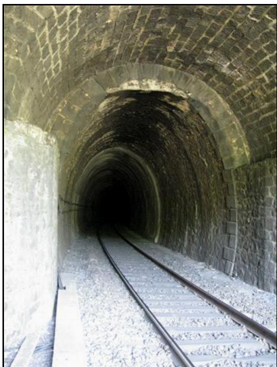
L'entrée du tunnel
