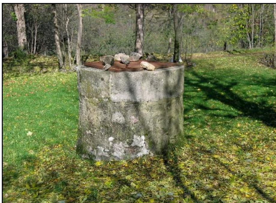
Ci-dessus et ci-dessous, sorties en surface des cheminées d'aération du tunnel
