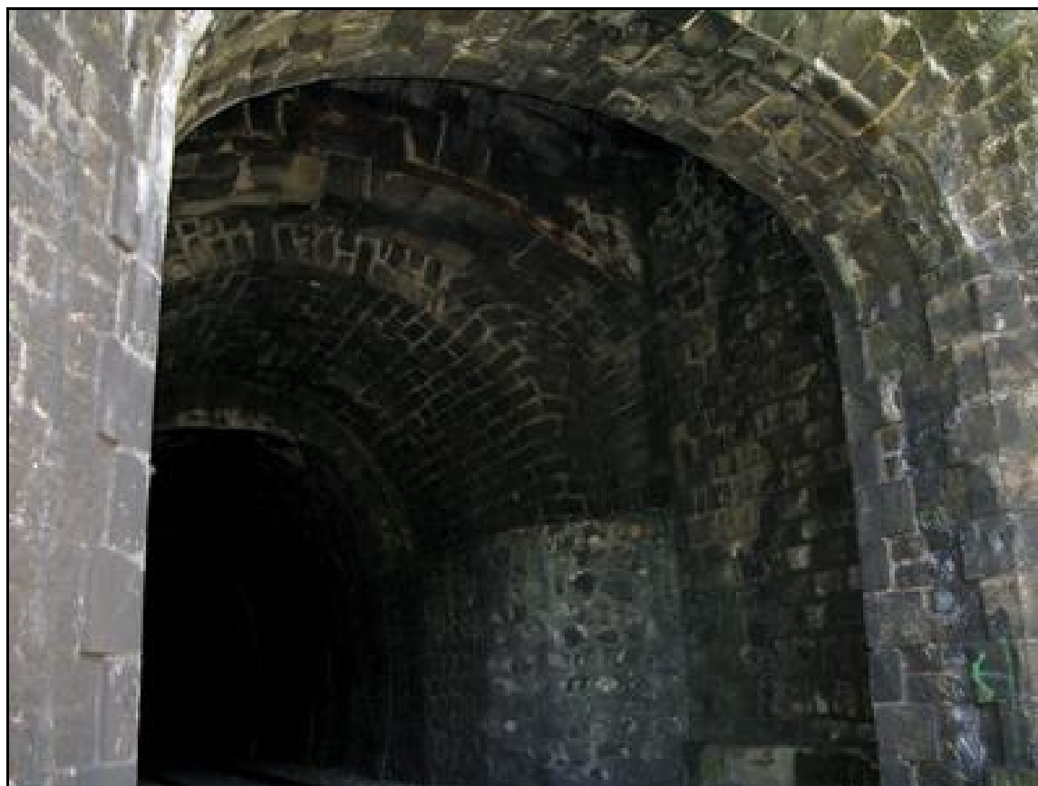
Emplacement aujourd'hui fermé du débouché de la tuyère dans l'entrée de la galerie du tunnel
