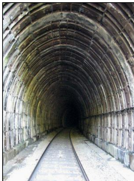
La sortie renforcée par des plaques de blindage
