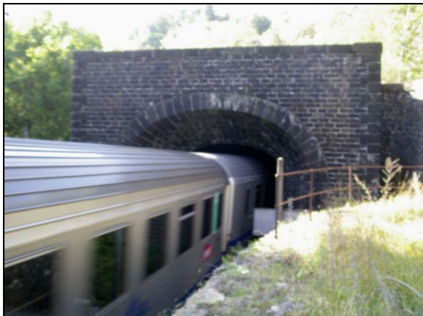
Un train entre dans le tunnel Noter le faible gabarit de la galerie qui laisse juste l'espace au train
