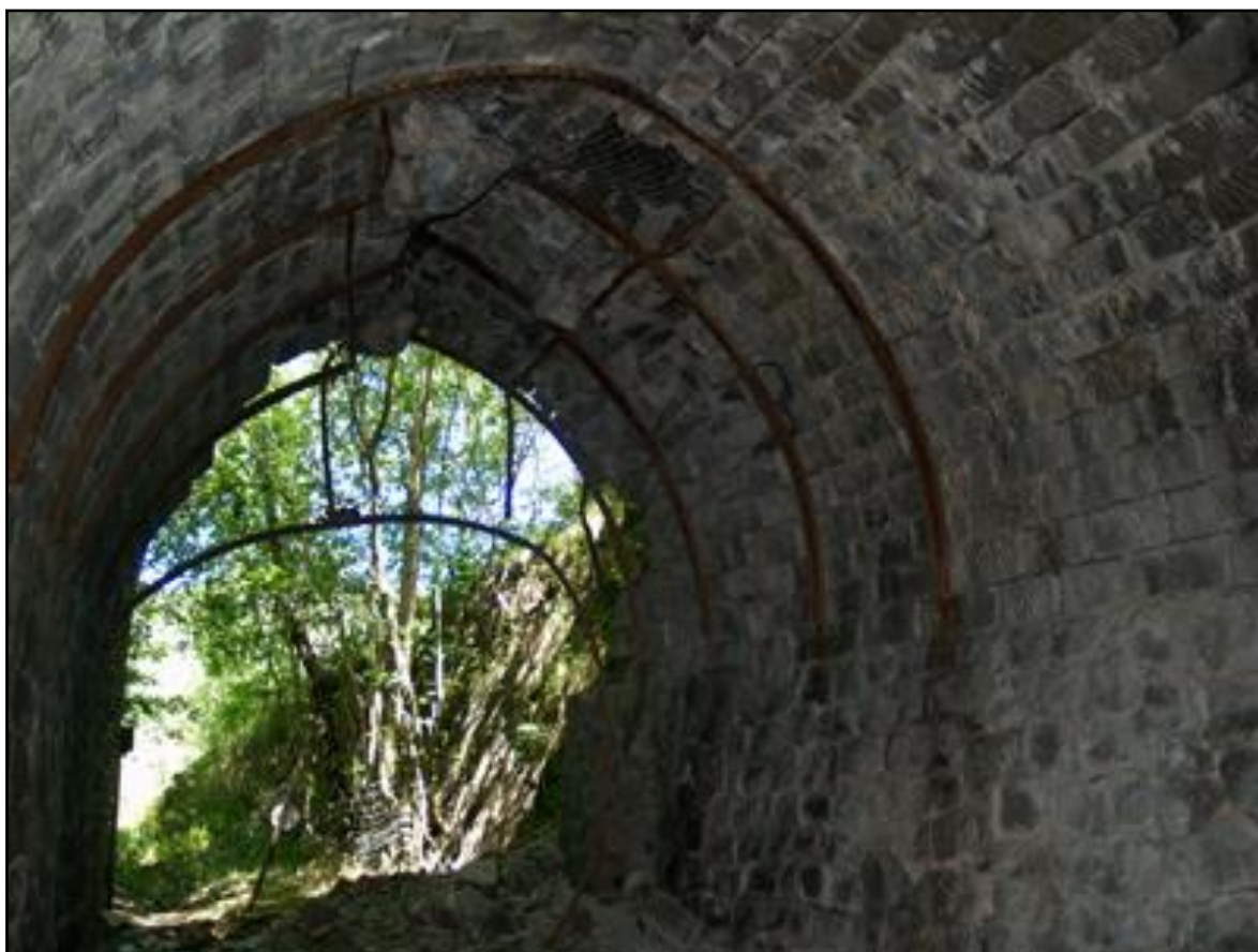
Ci-dessus et ci-dessous, l'intérieur de la galerie passablement abîmé et dangereux avec ses cintres de soutènement disloqués
