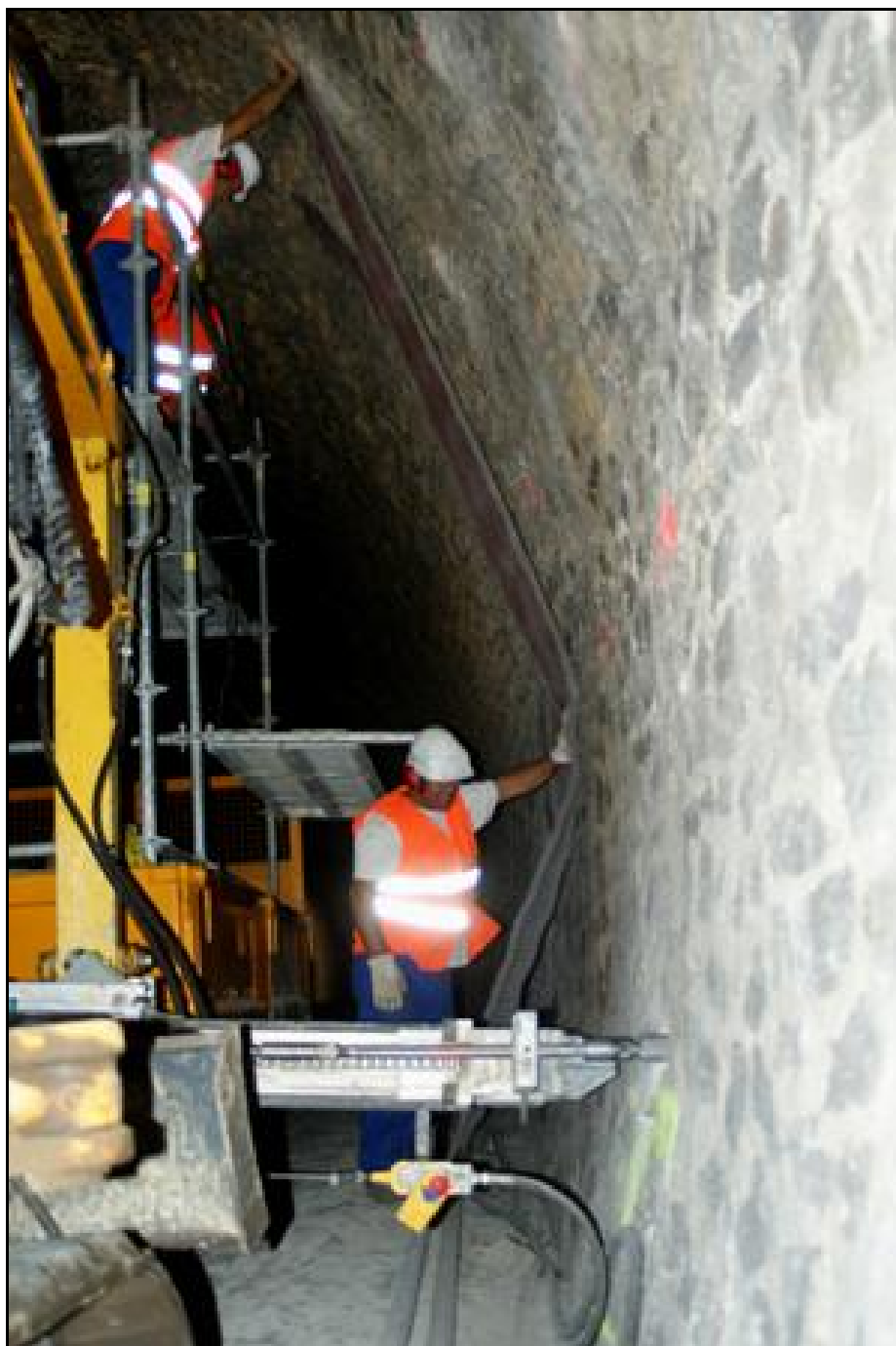
Pose d'une bande défectrice de ruissellement pendant que le perforateur fait un trou
