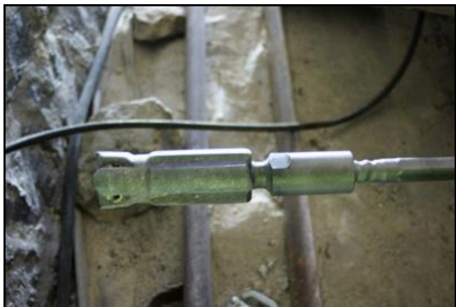
Gros plan sur la mèche du perforateur
