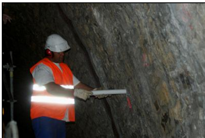
Pose d'un drain d'assainissement dans un trou fait au perforateur
