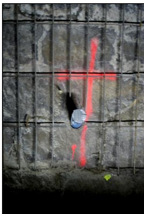
Drain et bande déflectrice sous le treillage métallique destiné à recevoir la coque en béton
