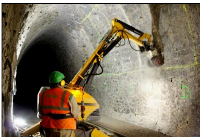
Rescindement des piédroits à la haveuse rotative Sur la photo de gauche, la bande travail, 5 x 2 m, marquée en jaune est bien visible Sur la photo de droite, noter l'usure de certaines dents qui sont carrément cassées
