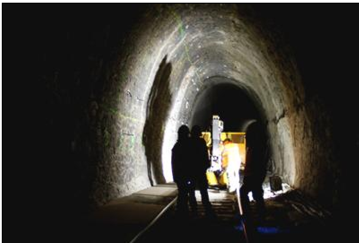
La galerie dans son état primitif lors d'un déplacement du lorry échafaudage
