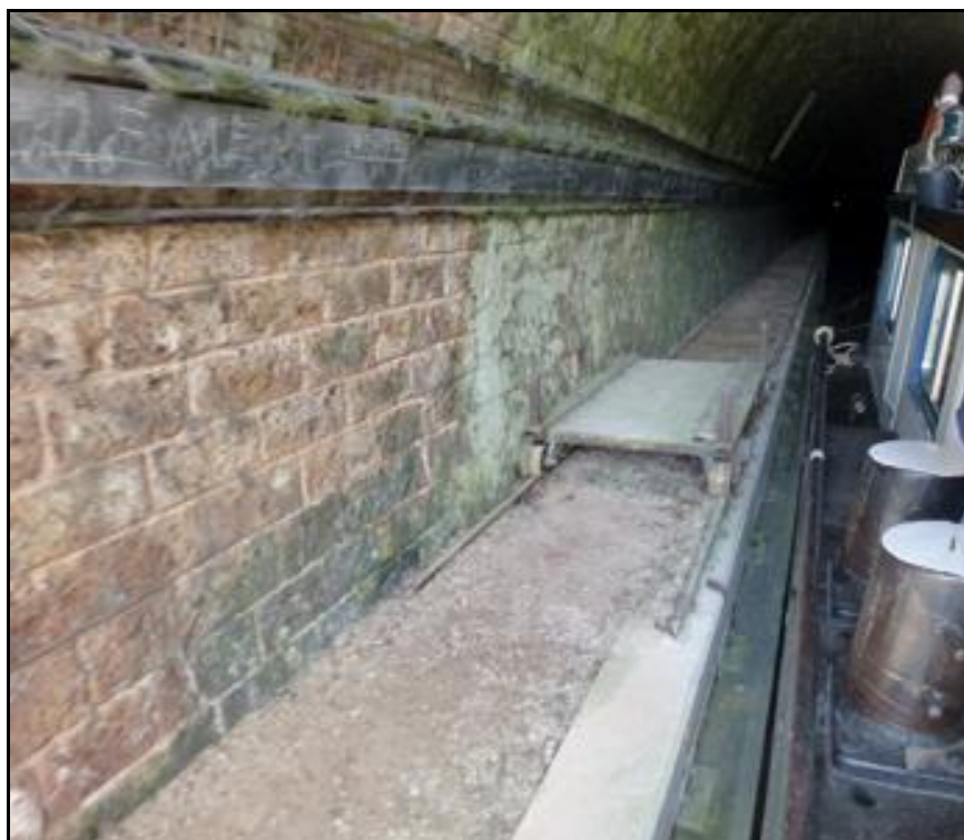
Ce qui reste de la voie ferrée de halage avec un chariot destiné à l'entretien de la voûte
