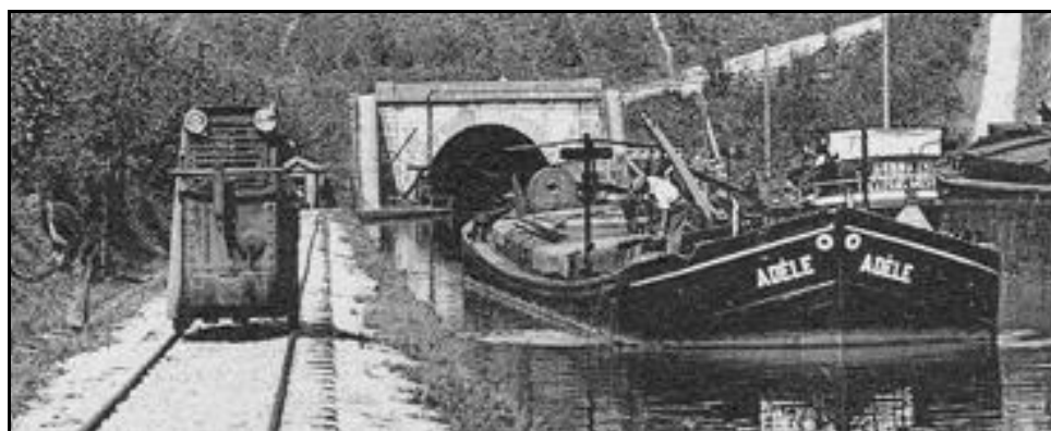
Ce qui reste de la voie ferrée de halage avec un chariot destiné à l'entretien de la voûte
