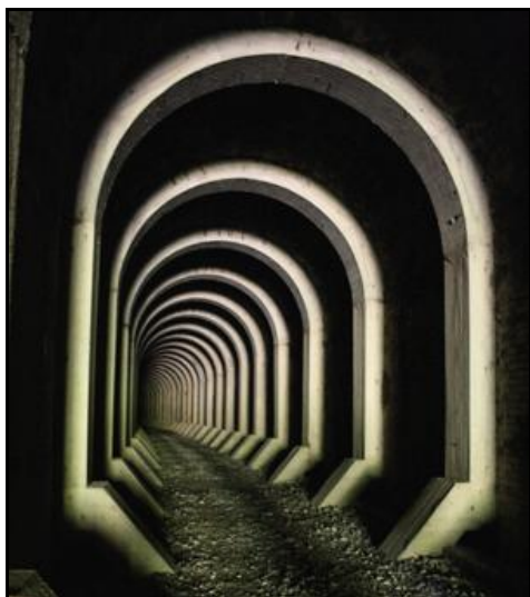
Ci-dessus et ci-dessous, la galerie primitive et renforcée par des anneaux en béton
