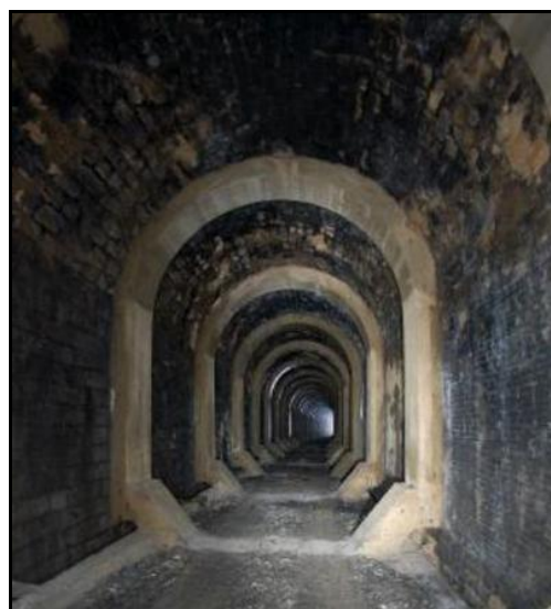
Ci-dessus et ci-dessous, la galerie primitive et renforcée par des anneaux en béton
