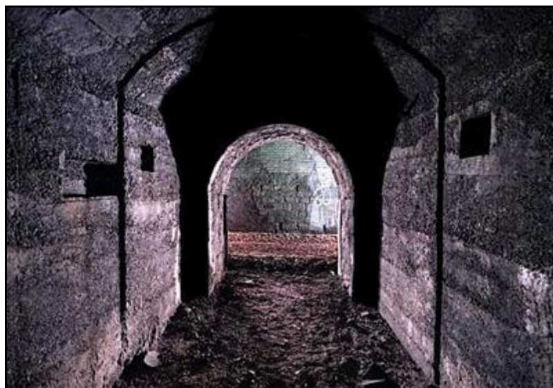
L'une des onze galeries de jonction de 5 m de long regardant ici vers l'ancien tunnel abandonné
