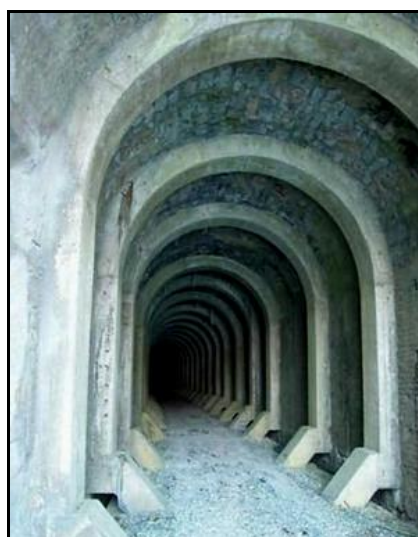
Ci-dessus et ci-dessous, la galerie primitive et renforcée par des anneaux en béton
