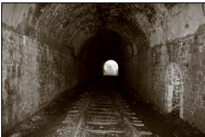
Ci-dessus et ci-dessous, la galerie primitive et renforcée par des anneaux en béton
