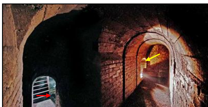
Fourneau latéral (flèche jaune) et son accès La flèche rouge désigne l'antichambre donnant sur le tunnel
