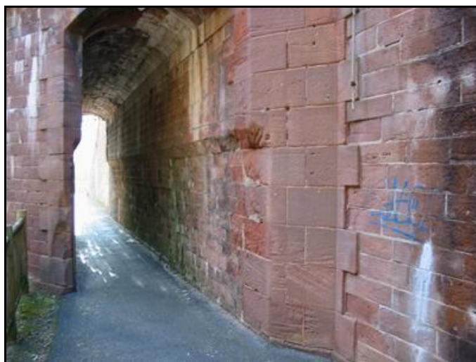
Détail de la galerie élargie de façon grossière pour permettre le passage des locotracteurs Decauville de halage
