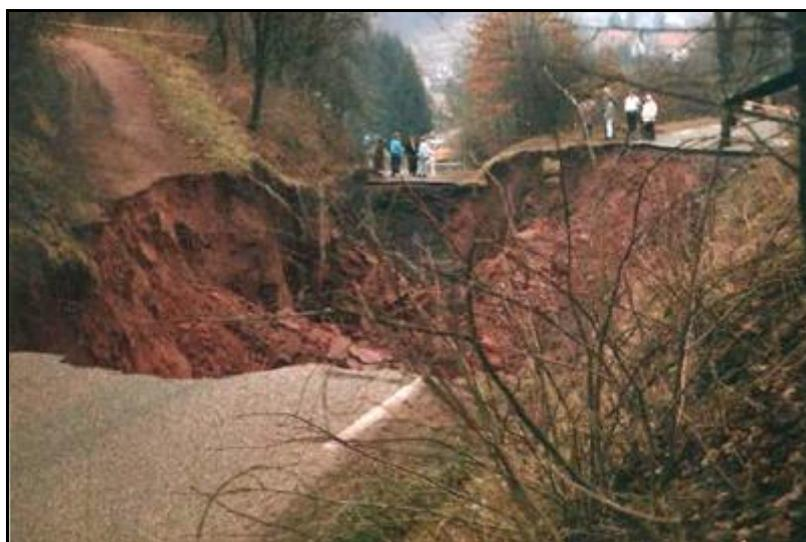
La cause évidente est le mauvais état de ce tunnel toujours connu pour ses nombreuses infiltrations et sans entretien depuis 13 ans. Cause peut-être aggravée par la présence voisine d'un réservoir d'eau souterrain qui présentait d'importantes pertes depuis quelques temps. Il se peut donc que de l'eau ait envahi et affaibli le sous-sol, et que le gel en cette période hivernale ait créé des mouvements de terrain qui ont provoqué une rupture de la voûte ou d'un piédroit.
