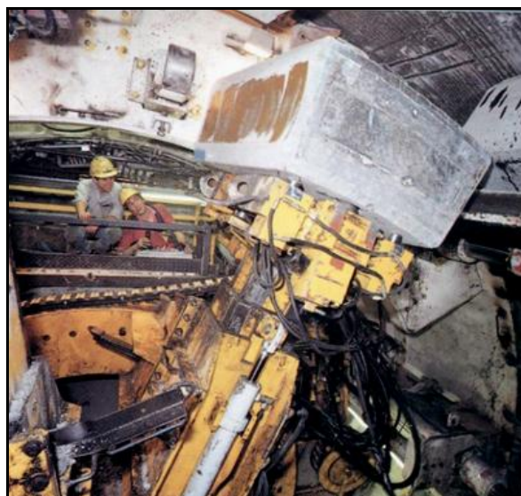
Pose de voussoirs à l'arrière d'un tunnelier
