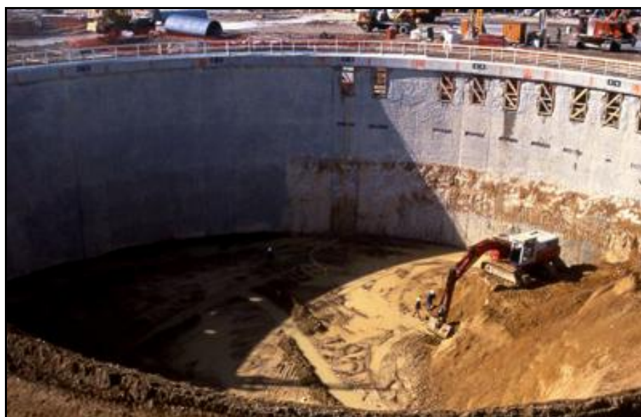
Ci-dessus et ci-dessous, début de la réalisation du puits de Sangatte
