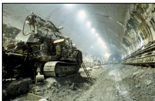
Chantier d'un cross-over en cours de creusement
