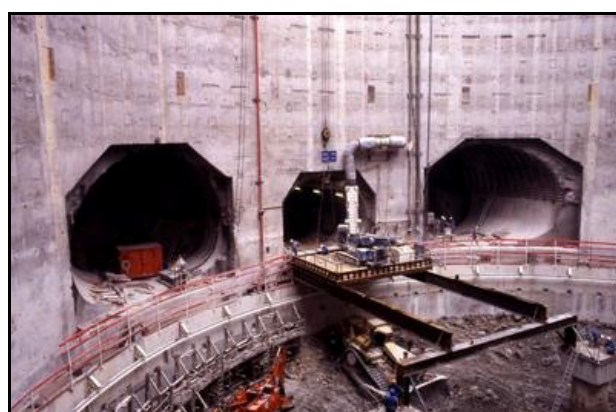
Le fond du puits avec les deux galeries ferroviaires latérales et la galerie de service centrale
