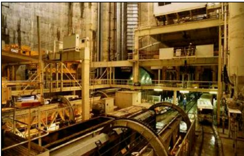
Le fond du puits aménagé pour les travaux On devine le départ des galeries à l'arrière-plan Au premier plan, les culbuteurs pour vider les berlines de déblais par retournement
