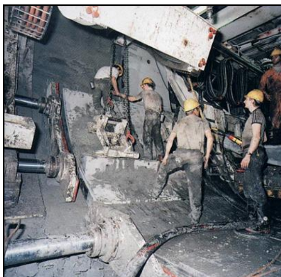
Pose de voussoirs à l'arrière d'un tunnelier
