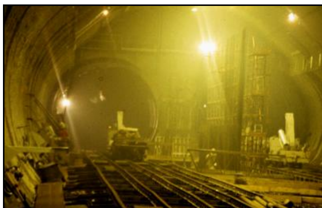
Chantier d'un cross-over en cours de creusement
