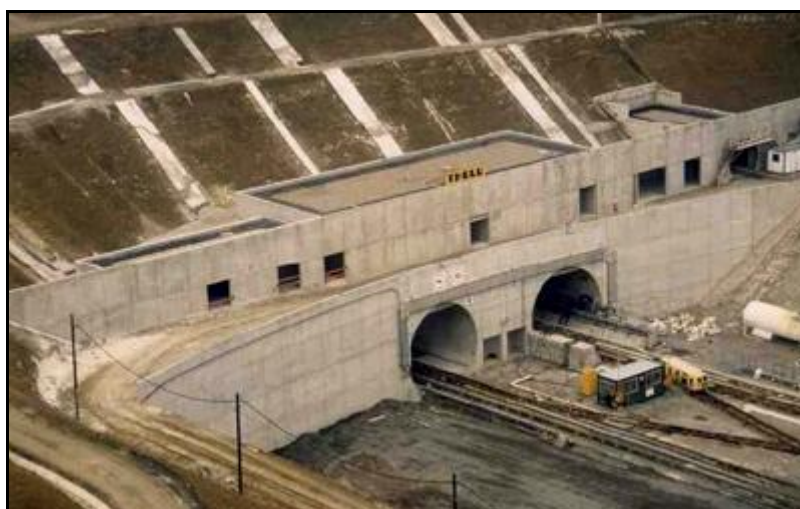
Les entrées des deux galerie du temps de la construction Les voies métriques visibles ici sont celles du chantier
