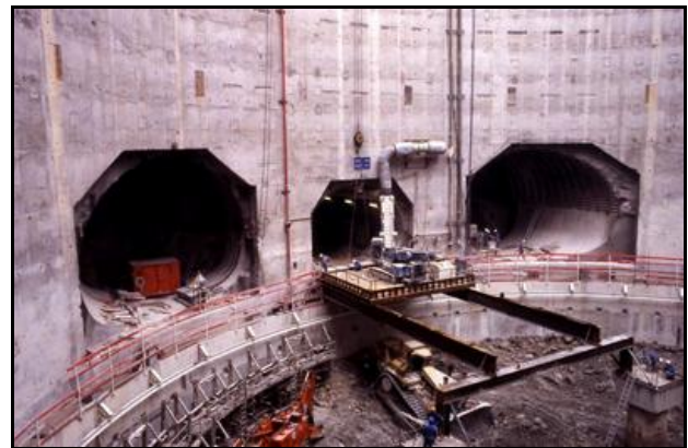
Le fond du puits avec les deux galeries ferroviaires latérales et la galerie de service centrale
