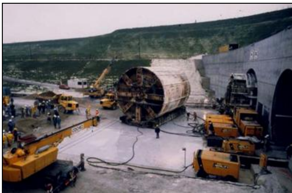
Mise en place d'un tunnelier à l'entrée des galeries
