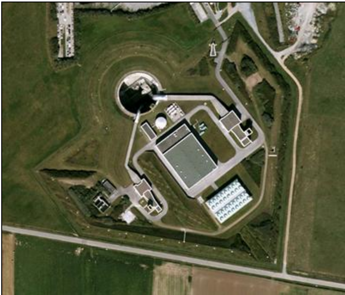
Vue aérienne actuelle du puits reconverti en système technique de maintenance
