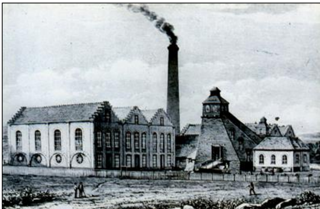
L'usine et le chevalement de Sangatte pour le creusement du tunnel sous la Manche
