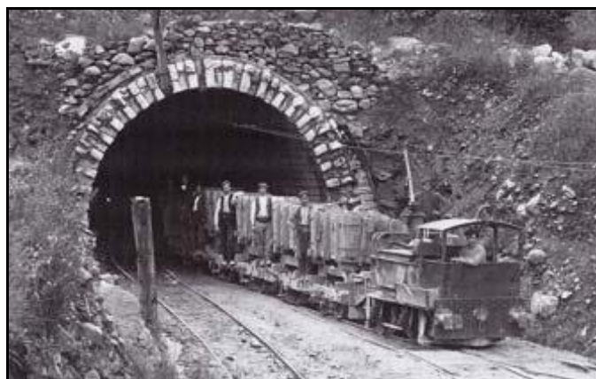
L'entrée du tunnel à deux stades différents de sa construction Notez que le radier n'est pas encore totalement abaissé
