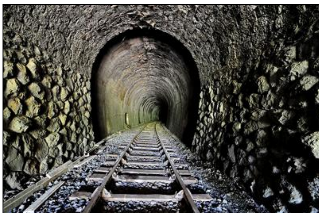
L'intérieur de la galerie vue depuis la sortie Au premier plan, la maçonnerie correspondant au fronton de sortie du tunnel
