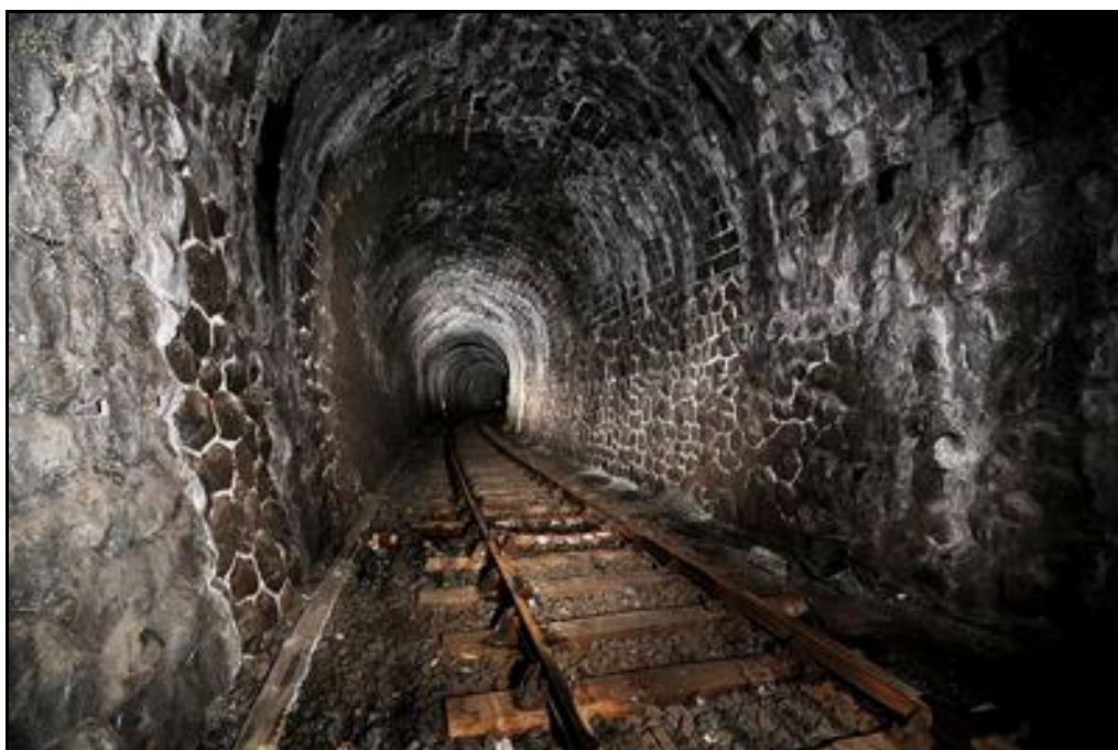
Une galerie courbe avec des niches généreuses Noter la dissymétrie de la niche qui révèle la pente de la voie
