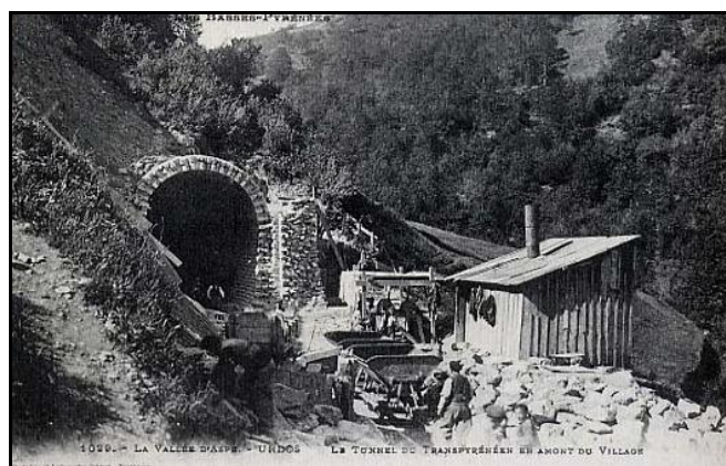
Ci-contre, l'entrée du tunnel en construction
