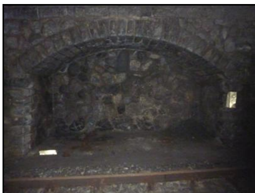
Une galerie courbe avec des niches généreuses Noter la dissymétrie de la niche qui révèle la pente de la voie
