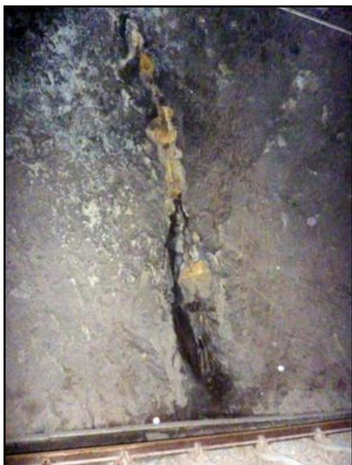
Ci-contre, à environ 150 m de l'entrée, la paroi droite du tunnel recoupe une fissure naturelle du terrain (diaclyse ; point A sur le plan) qui correspond à une galerie de la grotte
