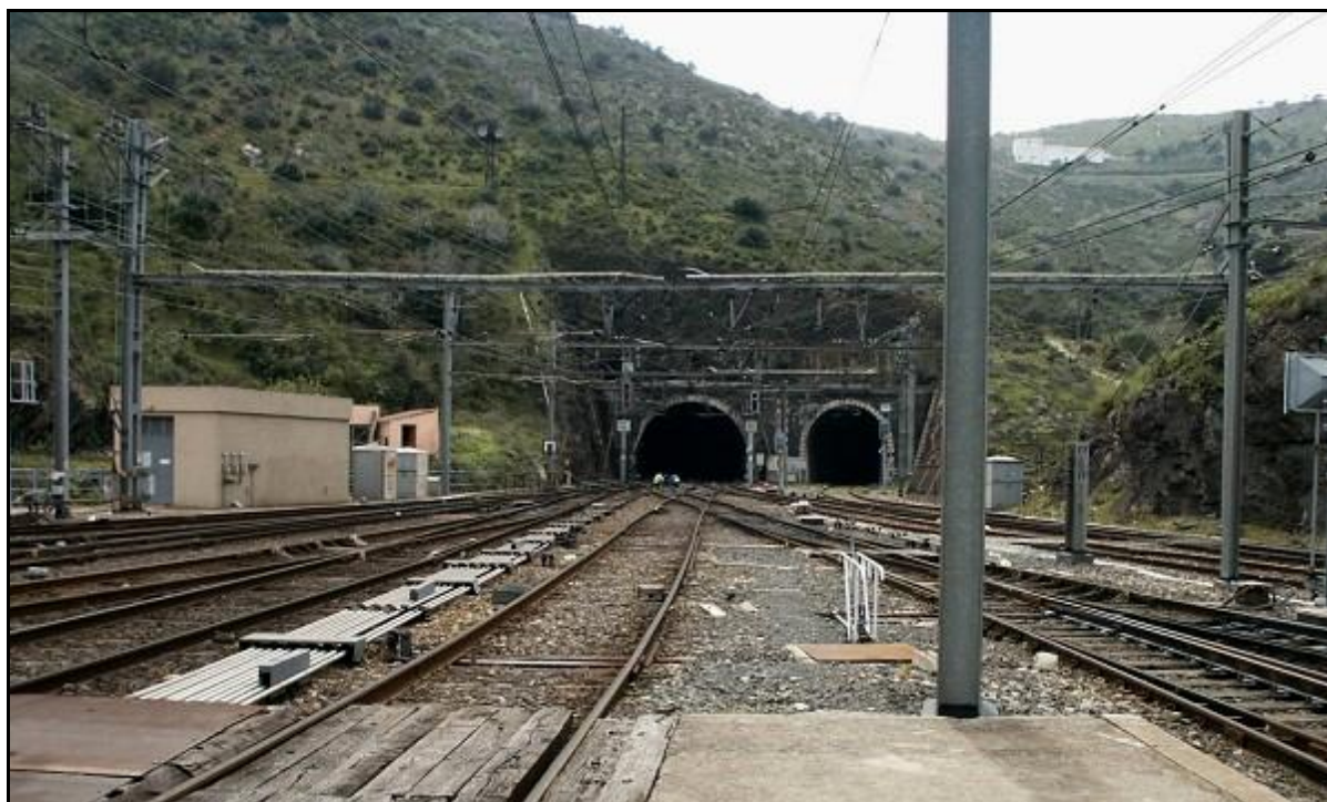
Entrées des tunnels de Balitres (à gauche) et de Balitres borgne (à droite) La voie au premier plan est à l'écartement espagnol
