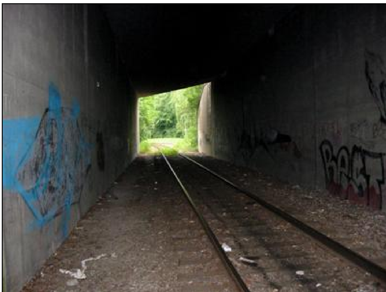
La galerie sous la rue de la Rochelle, vue de l'entrée vers sa sortie
