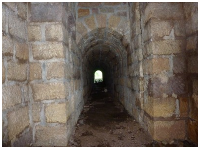
Située au-dessus de la voûte du tunnel, la galerie médiane est plane et conduit au fourneau de la voûte.
