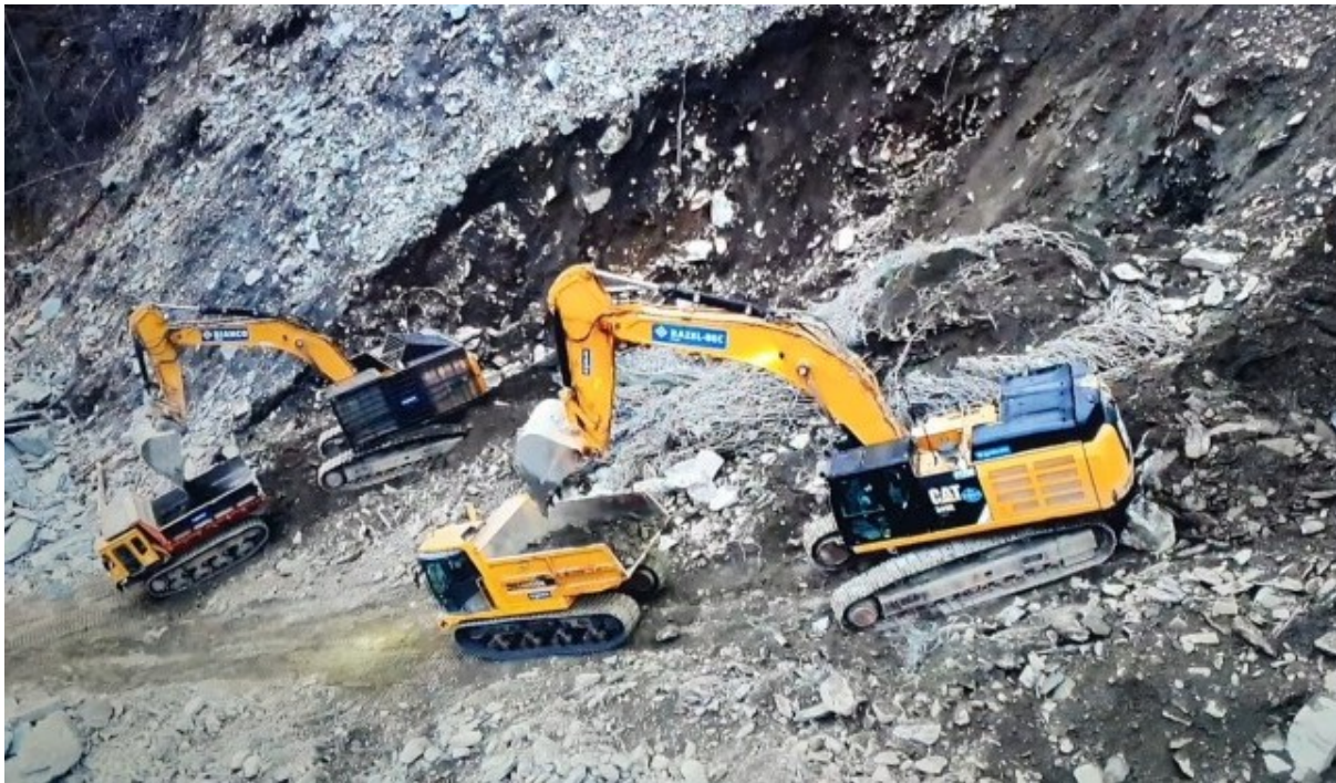
Utilisation d'engins télécommandés pour déblayer le cône d'éboulis sur la galerie
