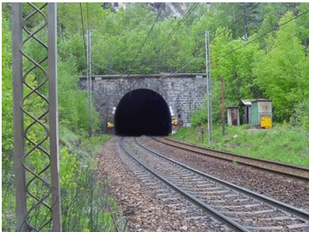
L'entrée du tunnel avant mise au gabarit pour le ferroutage
