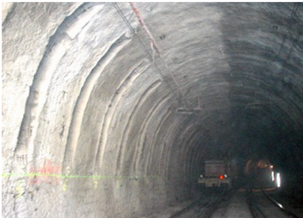
L'élargissement de la galerie et l'encastrement des renforts en béton ici bien visibles (travaux de 2002)
