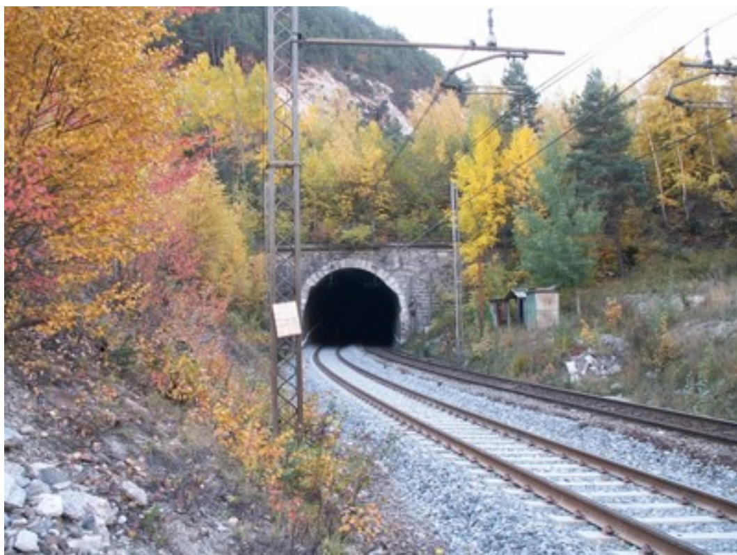
L'entrée du tunnel après sa mise au gabarit
