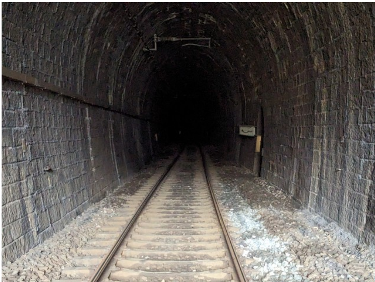
Vue depuis la sortie (16/11/2023)
