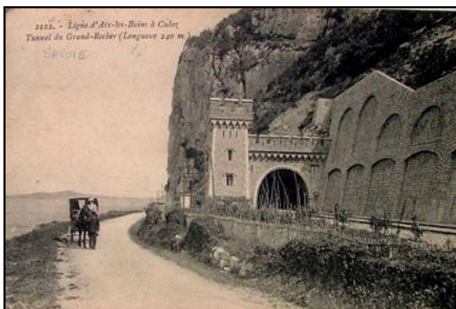
La sortie du tunnel dans son état initial
