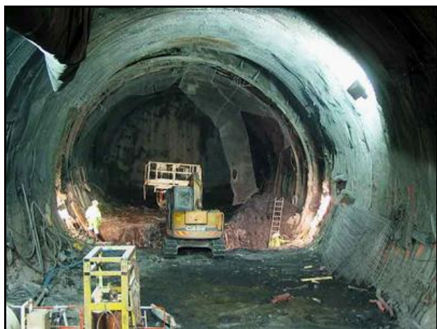
Phase de déblaiement
