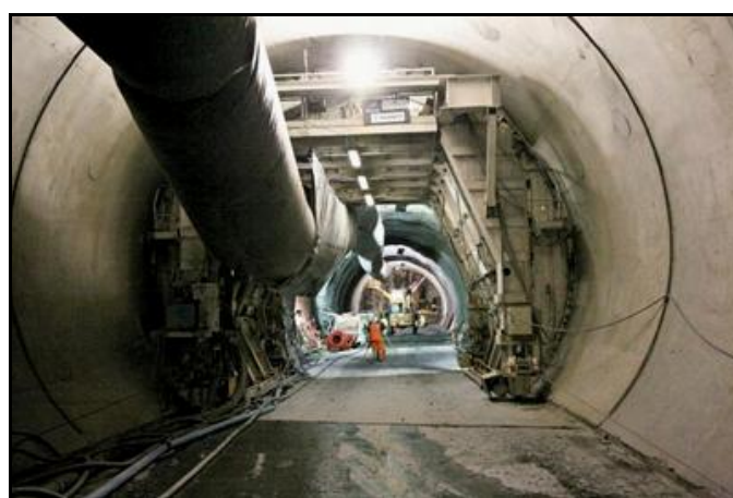
L'arrivée sur le chantier
