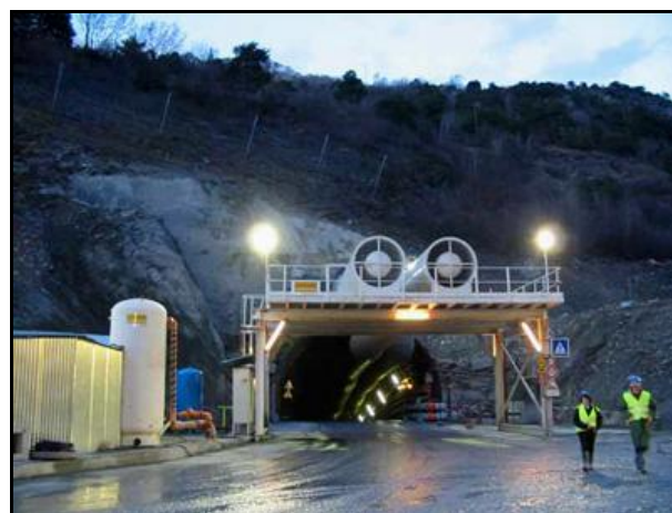
Entrée de la descenderie
