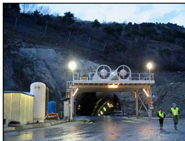
Entrée de la descenderie
