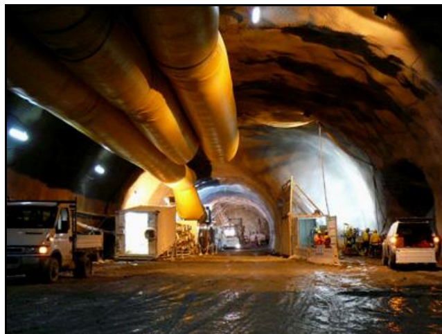
L'arrivée sur le chantier
