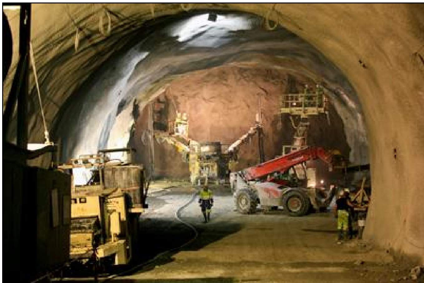
Vue globale du chantier
