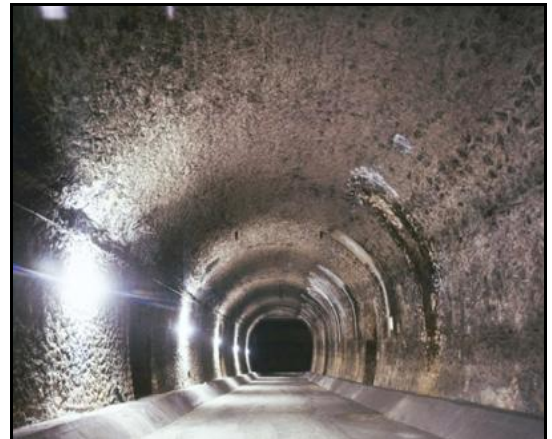
Ancien tunnel de métro en cours de réadaptation et terminé
