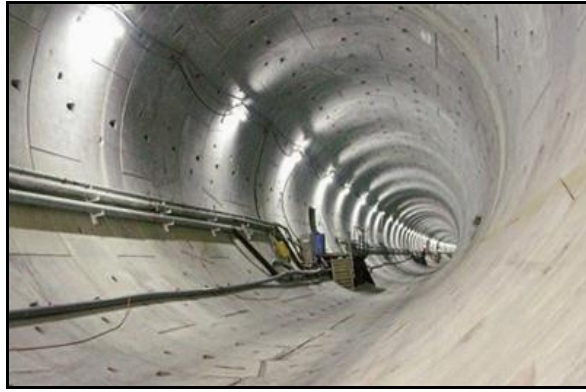
Galerie moderne creusée au tunnelier, d'où sa section initiale parfaitement circulaire Elle recevra un remplissage jusqu'à hauteur des tuyaux, puis une voie unique
