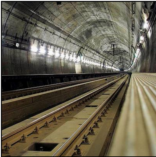
Galerie moderne creusée au tunnelier, d'où sa section initiale parfaitement circulaire Elle recevra un remplissage jusqu'à hauteur des tuyaux, puis une voie unique
