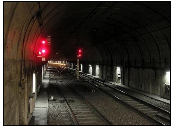
Ci-contre et ci-dessous, galeries à deux voies
