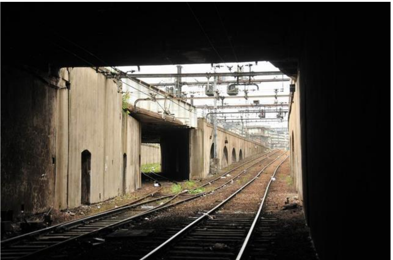
L'entrée vue depuis l'intérieur de la galerie
