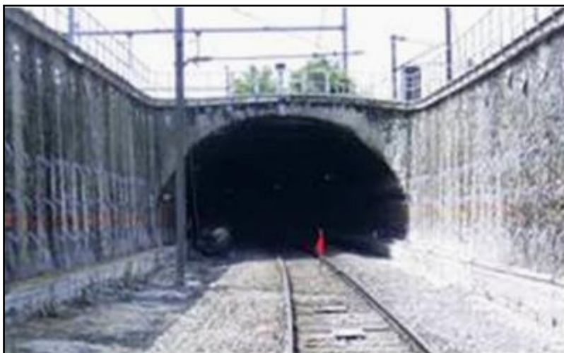
L'entrée avec le tunnel équipé d'une seule voie
