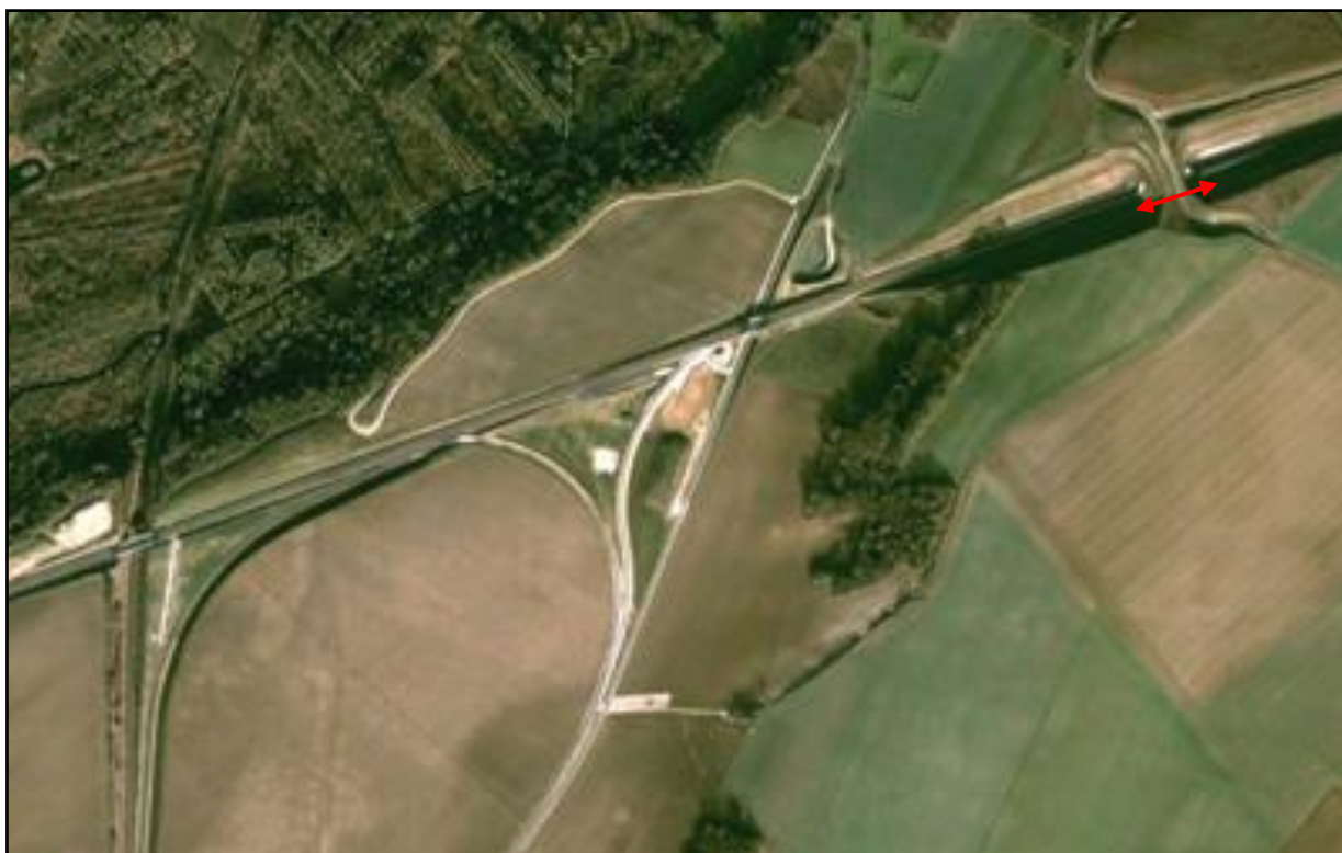
Vue aérienne du faux tunnel d'Ocquerre
