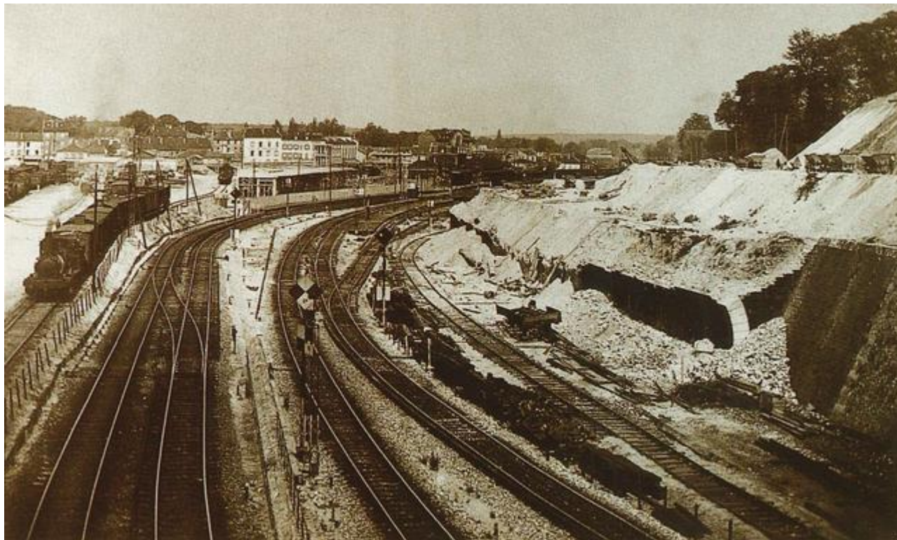
Destruction en cours du tunnel
