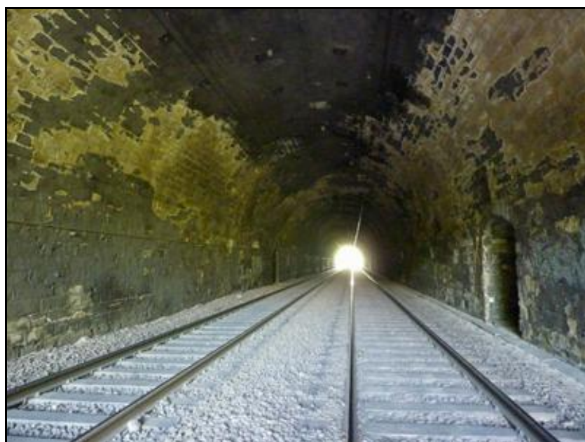
Ci-dessus et ci-dessous, deux vues de la superbe galerie du tunnel Noter sur la voûte, les traces persistantes de suie datant de la traction vapeur
