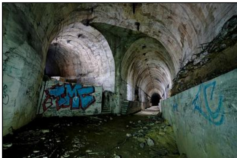
Quai de déchargement n° 1
