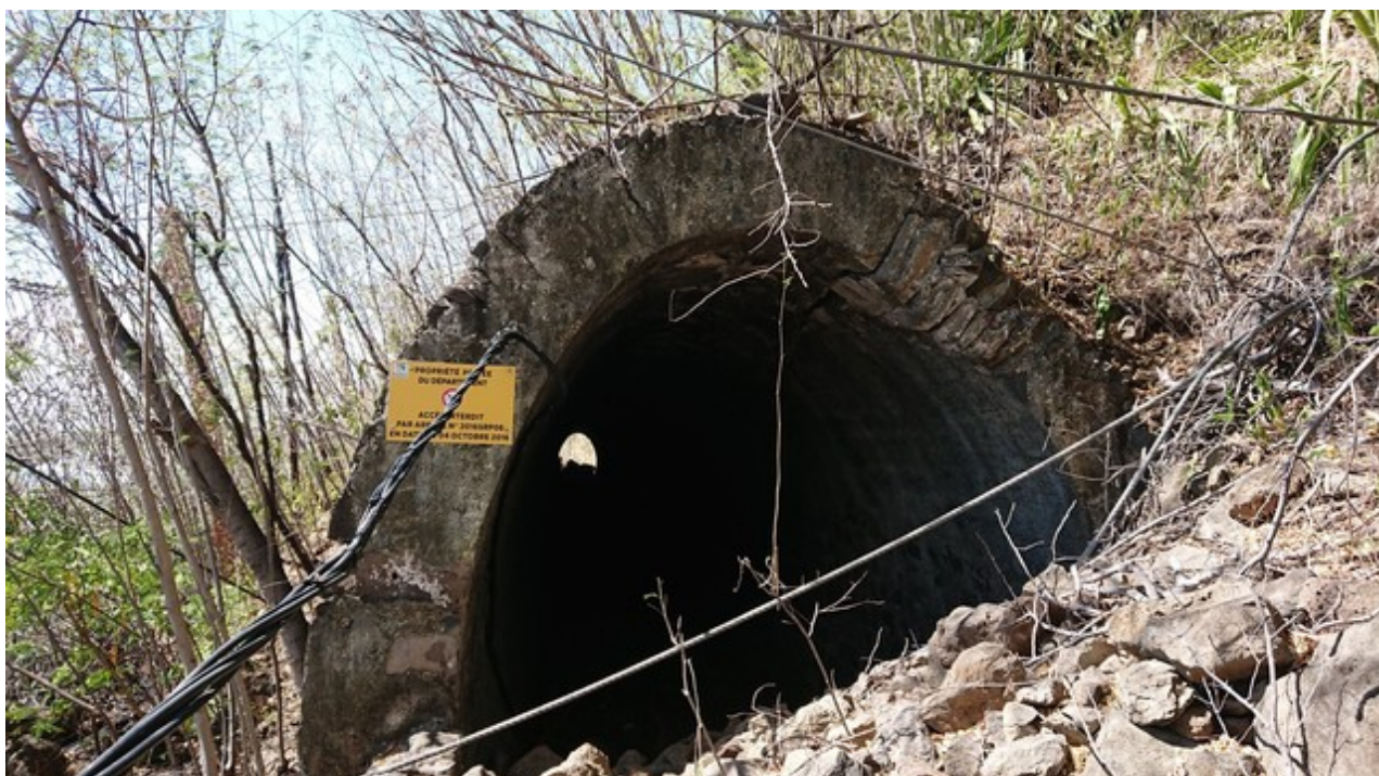
Photo de 2019 montrant la sortie du tunnel
