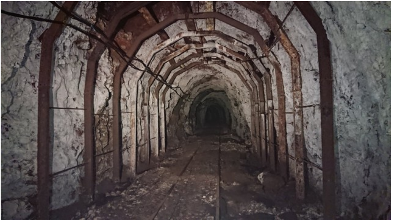
Une zone confortée par des cintres (2019)
