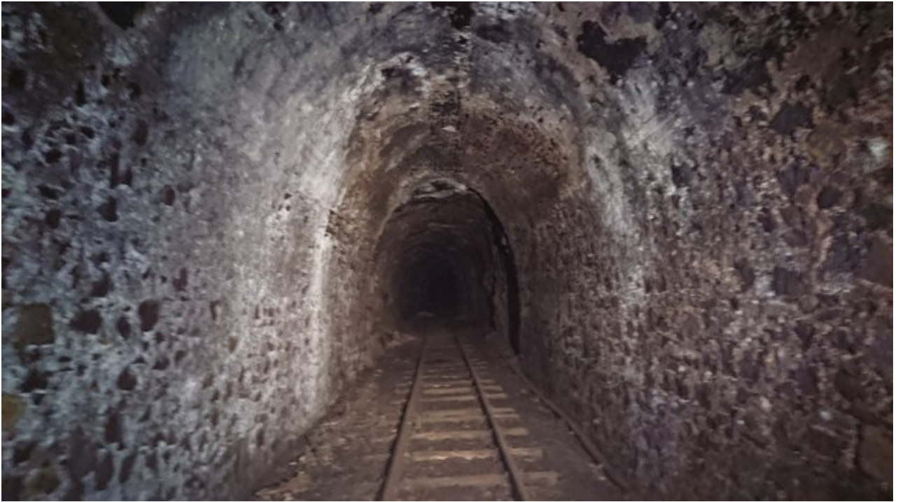
Une zone maçonnée (2019)
