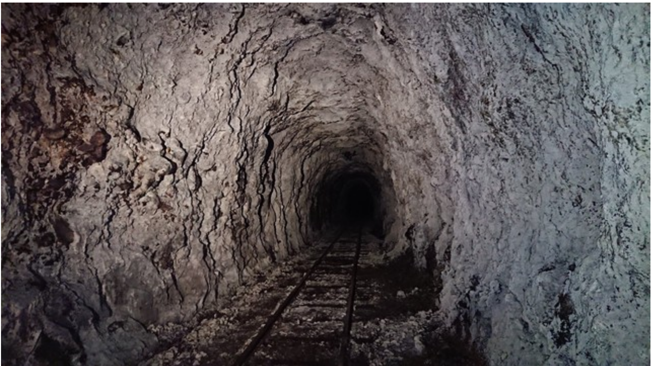
L'intérieur de la galerie à l'état brut en 2019
