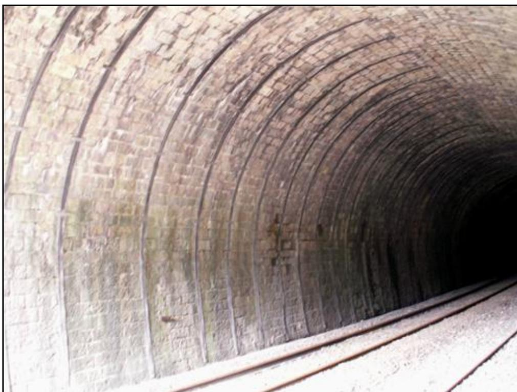
Saignées de drainage pour capter les eaux d'infiltration et assainir la voûte.
